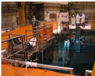
Piscine de stockage de combusti... fr.wikipedia.org
